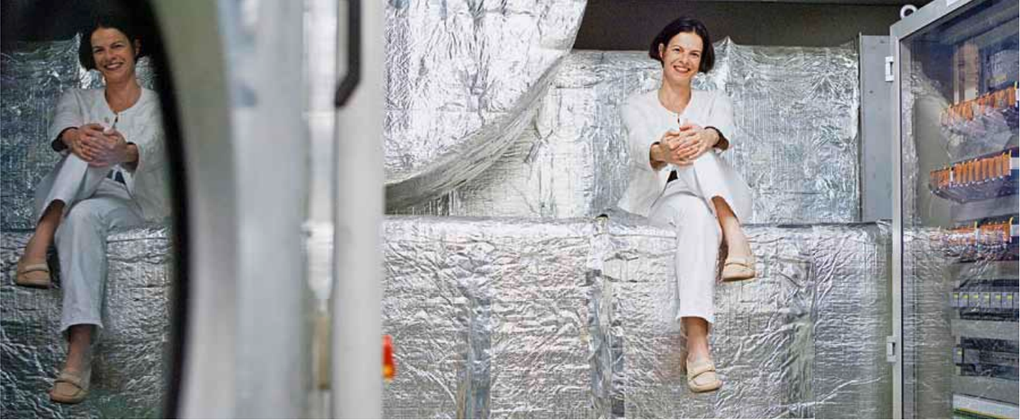
Ilona Jarabek in der Klimaschaltzentrale der MuK
